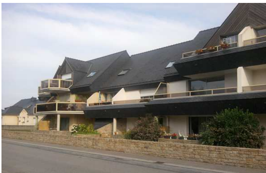
Collectif rue du parc
