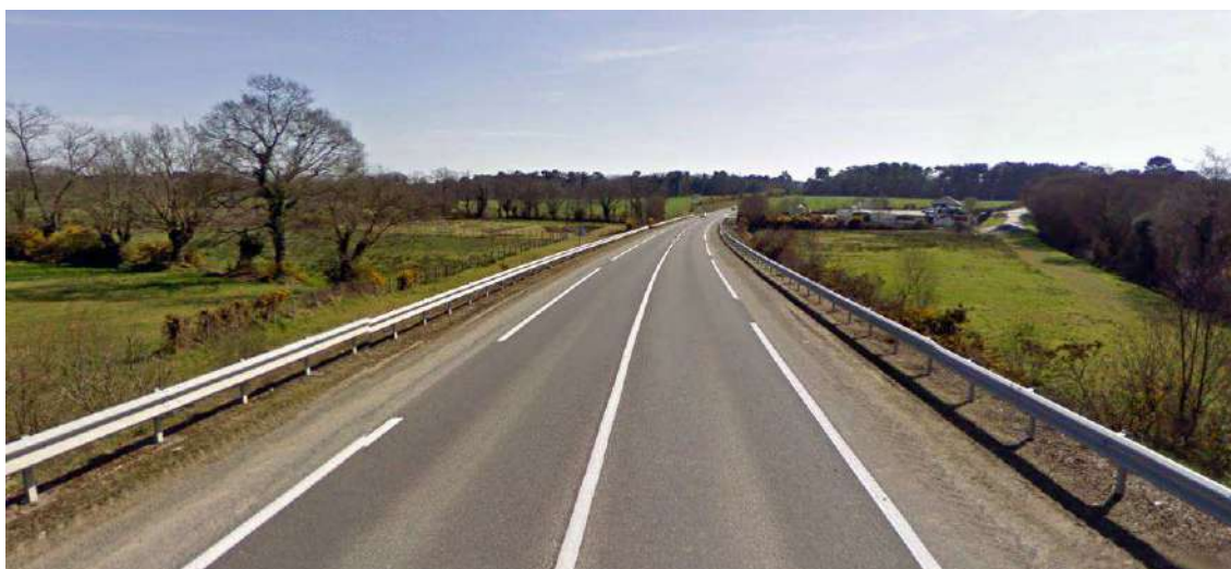
RD 17b - vue en direction du sud
